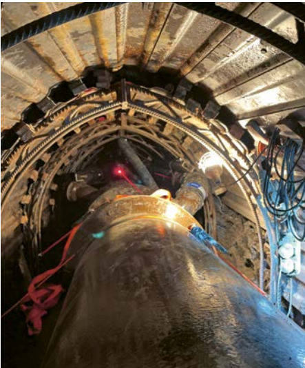
Kanalsanierung in Tunnelbauweise
