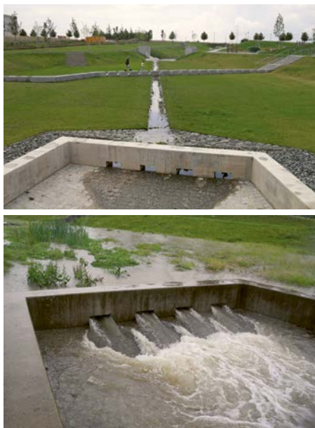
Frankfurt Riedberg: Rückhaltemulde, die bei Starkregen geflutet wird
