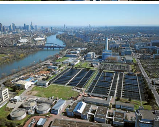
Abwasserreinigungsanlage Sindlingen (oben) und Niederrad (unten)
