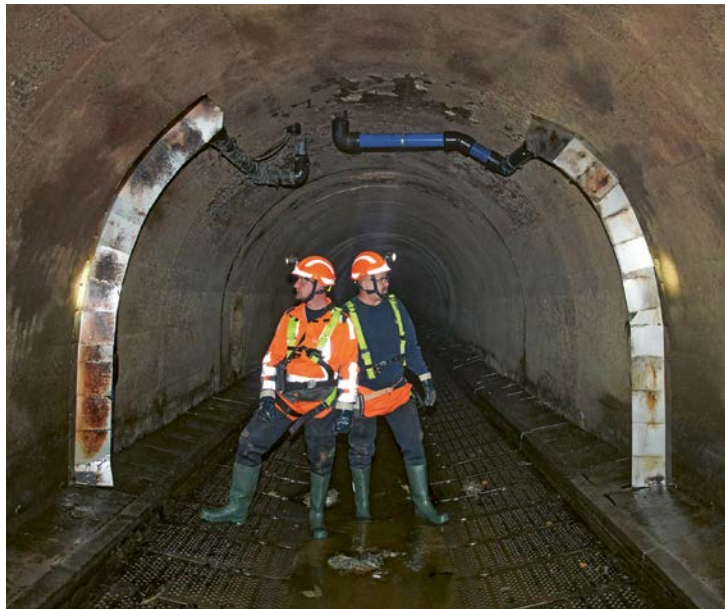
Wärmetauscher für die Gebäudeheizung im Haupt- sammler Gutleutstraße
