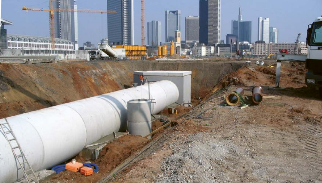
Kanalsanierung in offener Bauweise
