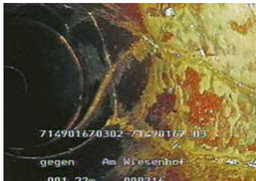
Rohrbruch und Risse sind typische Schäden in Zuleitungskanälen.
