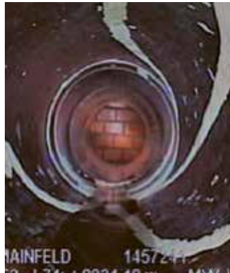
Sanierte Schadstellen
