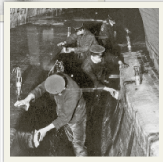
Um 1900 – Alles Handarbeit: Kanalreinigung mit Wurzelbürste und Reißigbesen.
