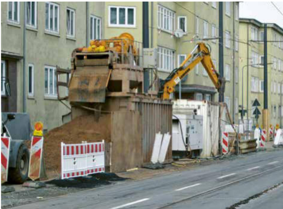
Kanalbaugrube mit Spundwandverbau
