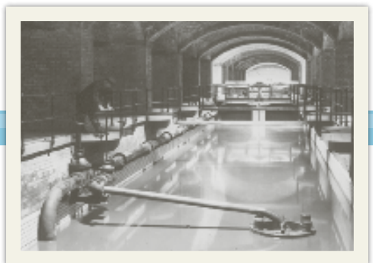
Erste Schritte zur Mechanisierung: die Flügelrechenanlage, eine Konstruktion Frankfurter Techniker (oben) und das Saug- und Druckleitungssystem mit Schwimmschlammsauger (unten)
