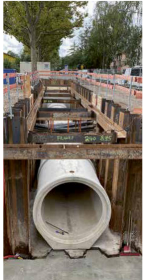
Kanalbaugrube mit Spundwandverbau
