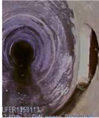
Sanierte Schadstellen
