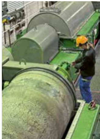
Links: Leistungsstarke Zentrifugen trennen den Schlamm in feste und flüssige Bestandteile.
