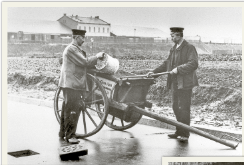
Um 1900 – Alles Handarbeit: Kanalreinigung mit Wurzelbürste und Reißigbesen.
