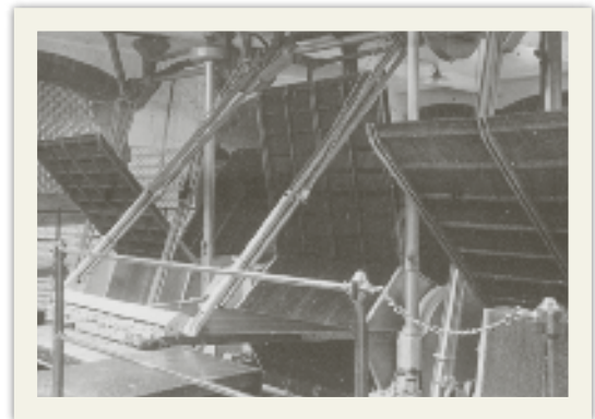
Erste Schritte zur Mechanisierung: die Flügelrechenanlage, eine Konstruktion Frankfurter Techniker (oben) und das Saug- und Druckleitungssystem mit Schwimmschlammsauger (unten)
