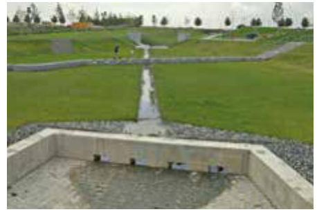
Rückhaltemulde, die bei Starkregen geflutet wird.
