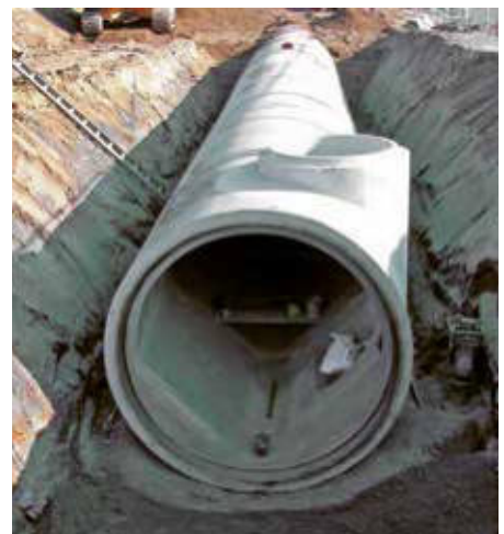
Kanalbaugrube im freien Gelände, geböscht
