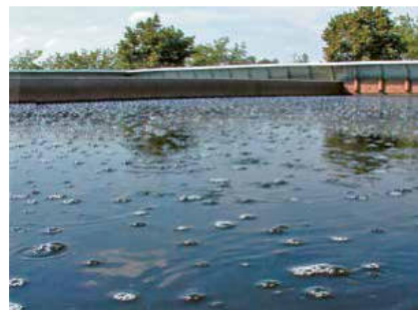
Im Filterbett der Denitrifikation wird Nitrat in Stickstoff umgewandelt, der in feinen Blasen ausgas-t.
