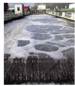
Schwimmstoffe treiben auf der Wasseroberfläche. Sie werden durch Räumler entfernt und in der **Schlamm-Entwässerungs- und Verbrennungs-Anlage SEVA** verbrannt.
